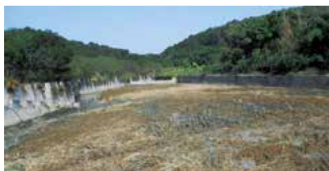
▲101年度通霄鎮福興里南勢溪上游野溪清疏等十區A-施工後
