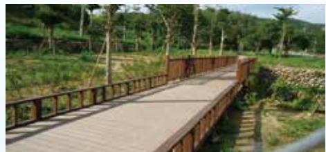
▲通霄鎮128線中點休憩站周邊環境改善工程
