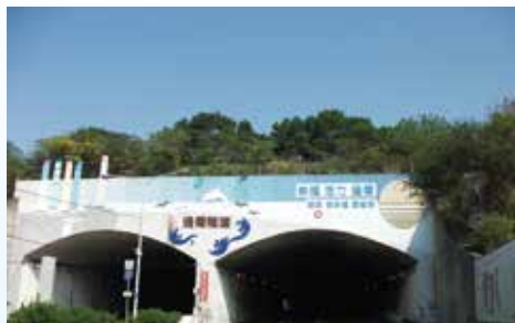
▲台一線路橋、路口及隧道口整修亮化
