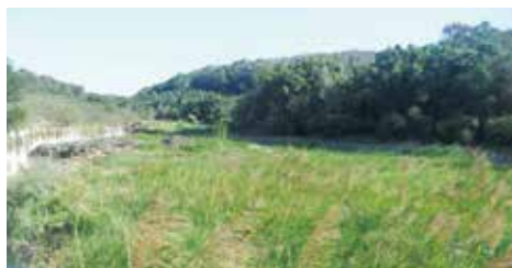
▲101年度通霄鎮福興里南勢溪上游野溪清疏等十區A-施工前
