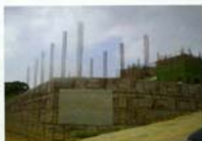
● 施工中的納骨堂
