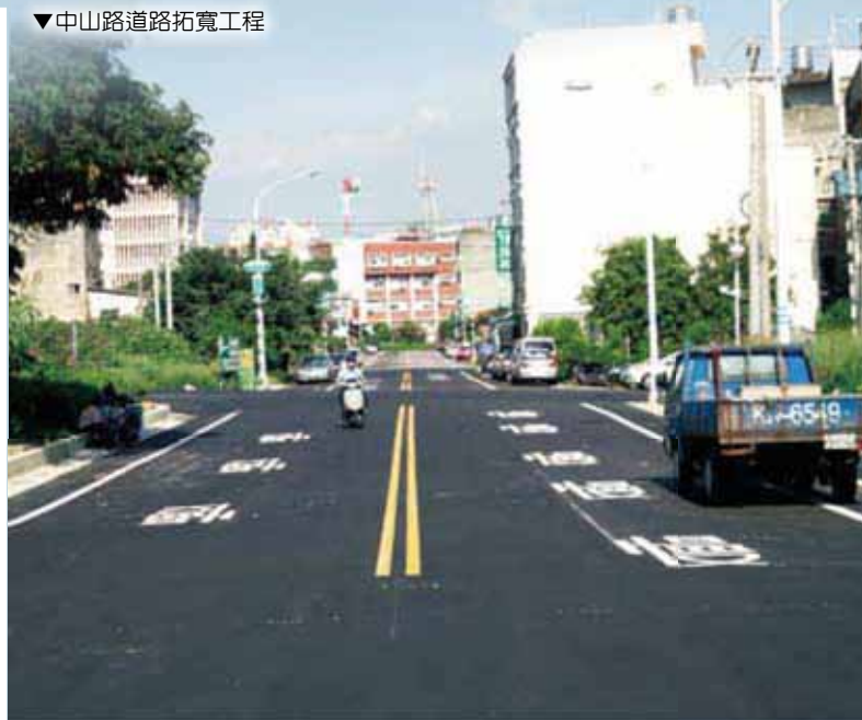
▼中山路道路拓寬工程
