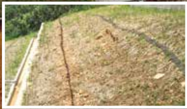
▲施工後植栽綠色植物
